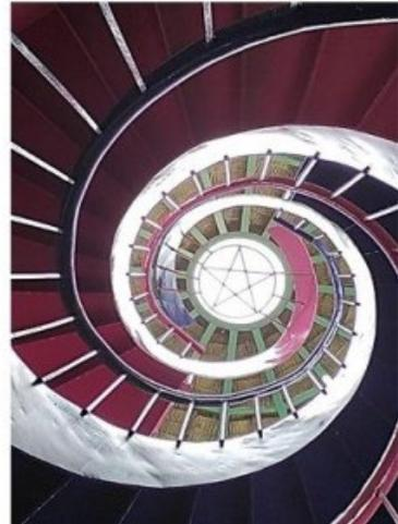
En el remate superior de las escaleras, estructuralmente requería tensores que evitaran la abertura de las bandas internas de las dos escaleras, entonces se recurrió de nuevo a la Geometría Sagrada con las figuras del círculo, el pentágulo y los rayos radiantes como las luz que ingresa por el domo central de 1m de diámetro.
